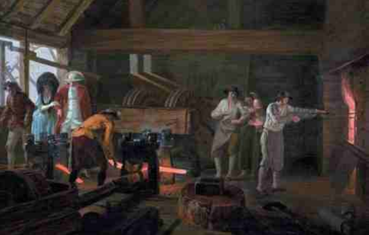
"Interior de una fundería". Léonard Defrance (Lieja 1735-1805). El cuadro representa la visita de los propietarios a una fundería, posiblemente situada en Lieja. La gran rueda hidráulica que se aprecia a través de la ventana, es la encargada de hacer rotar dos ruedas dentadas que se hallan en el interior del establecimiento, las cuales cambian el sentido de giro mediante otras dos ruedas, llamadas linternas o tambores de barras, en cuyo eje se hallan dispuestos los cilindros en los que el operario adelgaza el hierro.
