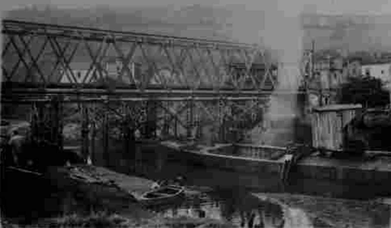
El puente de hierro de Le Creusot a comienzos de 1933. Se aprecia la estructura de madera para el montaje del nuevo puente . Colección Miguel Angel Martínez Vitores.
